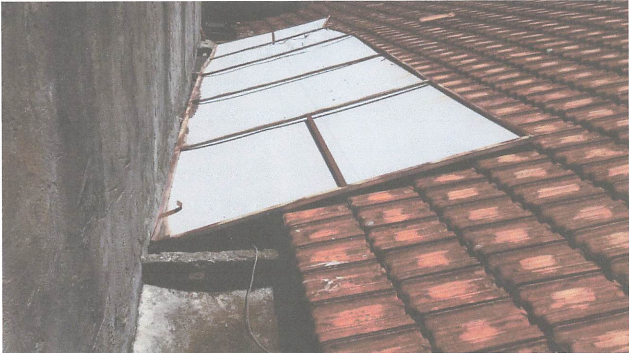
Foto 01: calhas em concreto a serem impermeabilizadas.
