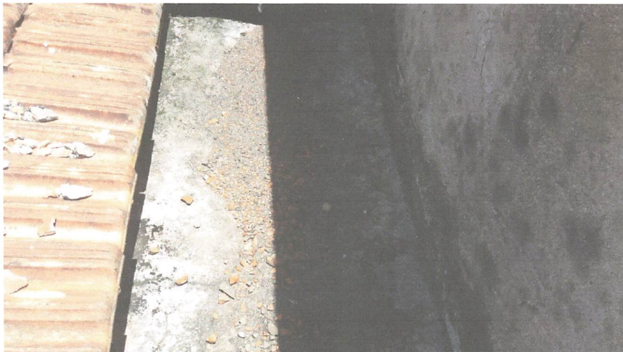
Foto 02: calhas em concreto a serem impermeabilizadas.
