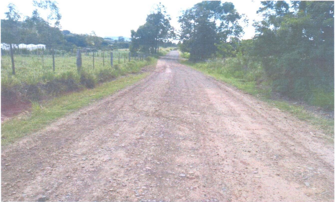
Foto 21 – Ponto P 201 final do trecho a pavimentar.
