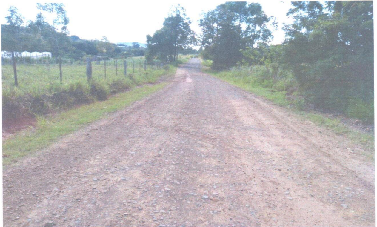
Foto 21 – Ponto P 201 final do trecho a pavimentar.
